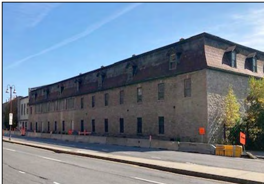
Bâtiment 6 pour l'entreposage et l'expédition des produits. Les trains peuvent y entrer.
