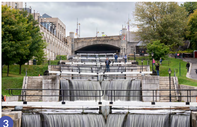
Vue en direction des biefs d'amont des écluses d'Ottawa, du pont Plaza et du Château Laurier.
