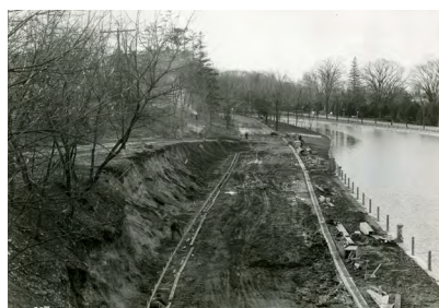
« Les travaux de construction sur la promenade Echo et sur la promenade du Colonel-By actuelle, dans le sens sud depuis la rue Bank », vers 1927-1932.
