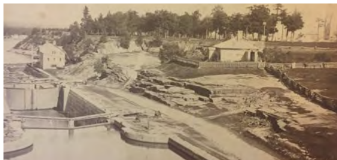
Panorama des écluses d'Ottawa depuis le pont des Sapeurs en 1864, dont la maison du colonel Coffin et le bureau du perceuteur (qui n'existent plus). Crédit : « Offert par Mme Montague Anderson », Archives de la Ville d'Ottawa, MG464-CA000224.
