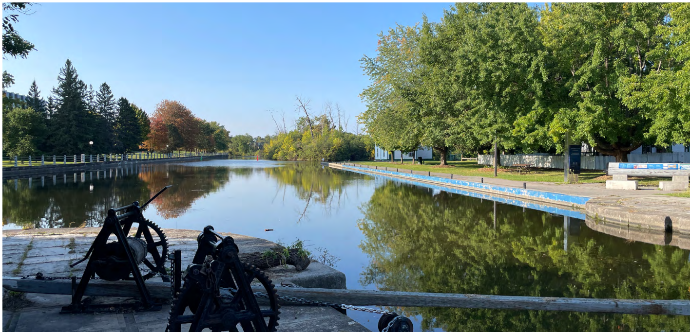
Poste d'éclusage de Hartwells. Crédit : CCN.
