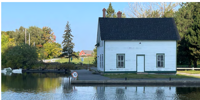
Le magasin général du poste d'éclusage de Hartwells; on aperçoit, derrière, la Ferme expérimentale centrale, en 2023. Crédit : Matrix Heritage.
