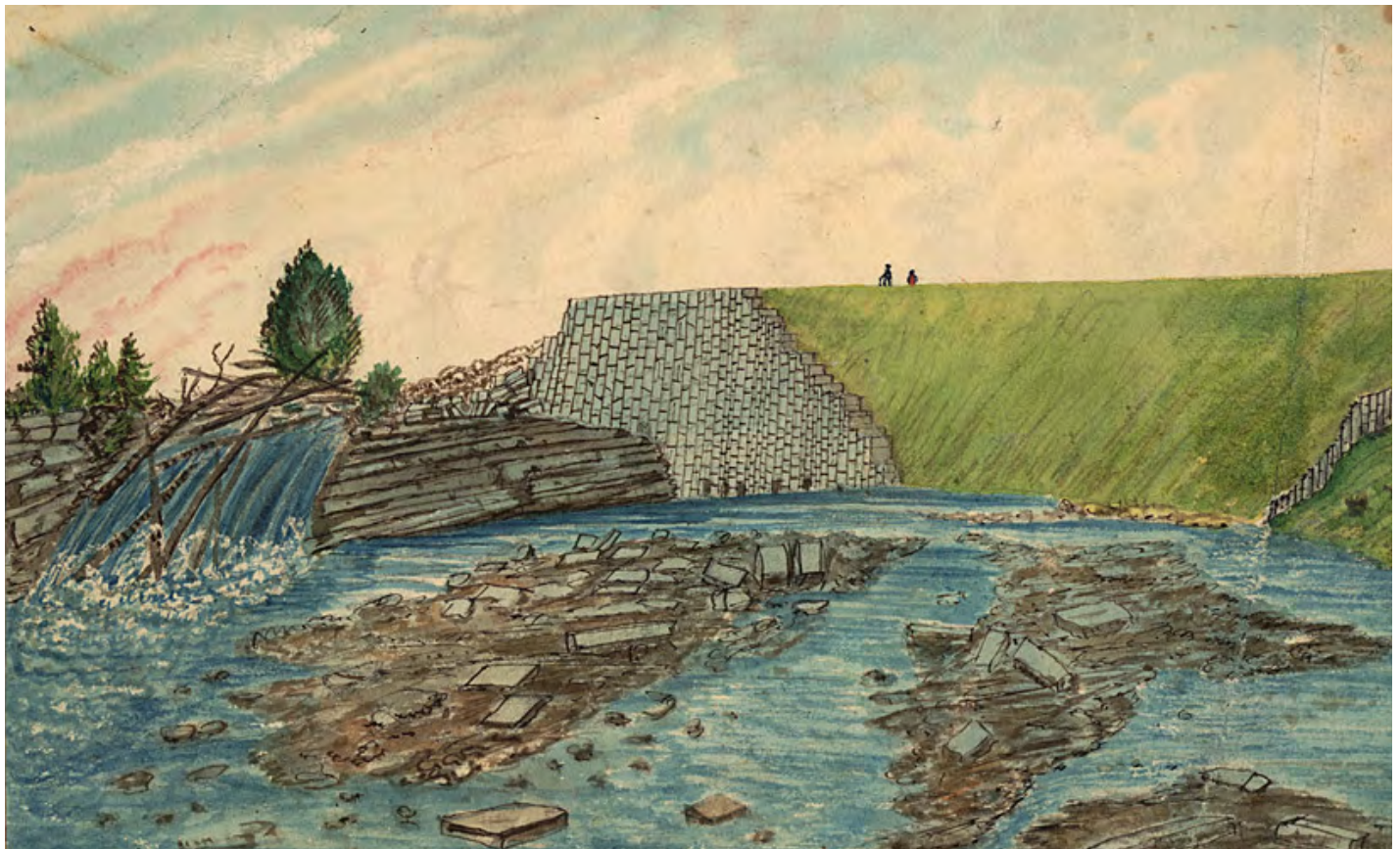
« Barrage du parc Hog's Back », représentant la brèche dans la maçonnerie de pierre en 1830. Croquis dessiné en juillet 1845 à partir du lit de la rivière. Crédit : Thomas Burrowes, Archives publiques de l'Ontario, dossier C 1-0-0-0-15.
