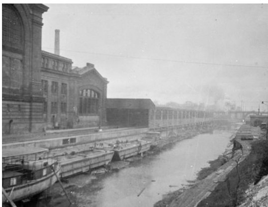
Le canal Rideau dans le sens sud en direction de la gare Union en 1927. Source : Clifford M. Johnston, Bibliothèque et Archives Canada, PA-056251.
