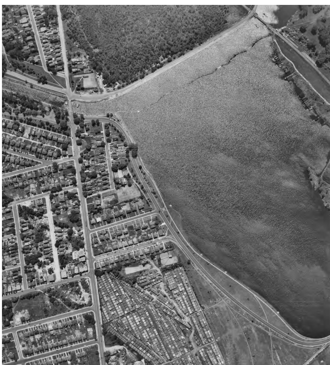
Vue à vol d'oiseau du lac Dow représentant les parties restantes des cours à bois en prévision de l'expansion des lotissements du lac Dow; le parc des Commissaires est en voie d'aménagement. Crédit : Photothèque nationale de l'air, A3332.49; consultée grâce à l'index de la Photothèque nationale de l'air (PNA) de l'Université d'Ottawa.
