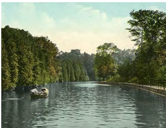
Panorama en carte postale du canal Rideau vers 1905, à l'est de l'avenue Bronson dans la tranchée de Mutchmor. Crédit : Archives de la Ville d'Ottawa, MG344-1-9-4.
