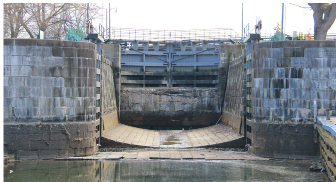
L'écluse asséchée du poste d'éclusage de Hog's Back, en mars 2024. Crédit : Matrix Heritage.
