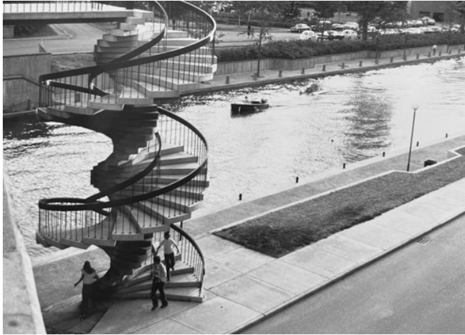
Escalier en colimaçon descendant depuis le pont Mackenzie-King jusqu'à la promenade du Colonel-By en 1980. Crédit : CCN.
